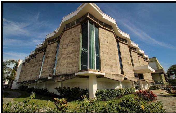
Figura 8. – Fachada externa do Ginásio de Esportes do IF Fluminense
