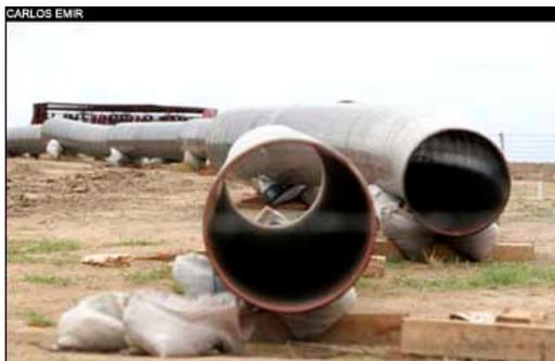
Tubos usados na construção do gasoduto Cabiúnas-Vitória (GASCAV)
