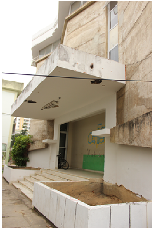
Foto 1 - Centro de Artes (Em Reforma)
