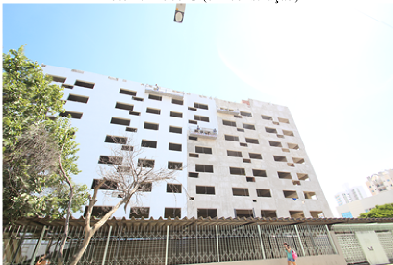
Foto 2. Bloco G (em construção)
